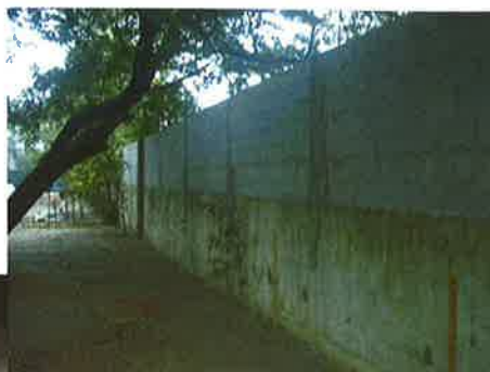
Muros de divisa
