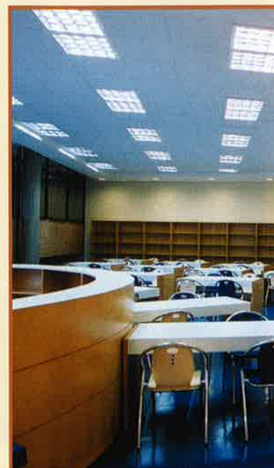
FASE FINAL DAS OBRAS DE REFORMA E MODERNIZAÇÃO DA BIBLIOTECA
