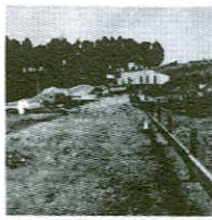
CONSTRUÇÃO DA PLATAFORMA DAS PISCINAS
