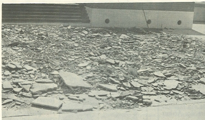
Através da impermeabilização o fundo da piscina recreativa, as goteiras do vestiário feminino serão eliminadas. Além disso, a pintura do quebra-ondas e das balizas, a troca da tubulação da casa das máquinas e a desobstrução dos ralos também estão programadas.
