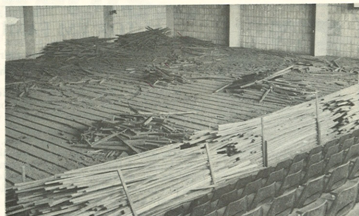
No ginásio antigo o piso deteriorado foi removido para que se pudesse revisar os drenos e executar a impermeabilização. Brevemente os caibros serão recolocados.
