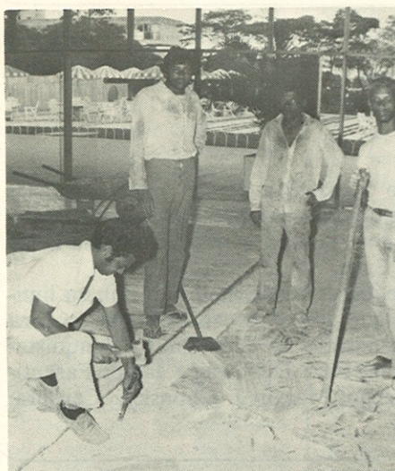
A antiga sala de pintura deu lugar à sala do balé, que está sendo ampliada.
