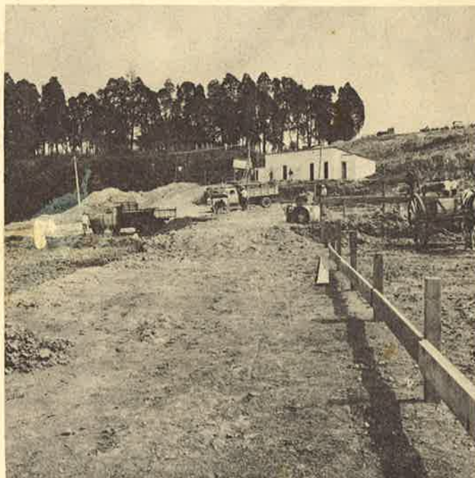
DEMARCAÇÃO DA PLATAFORMA DAS PISCINAS
