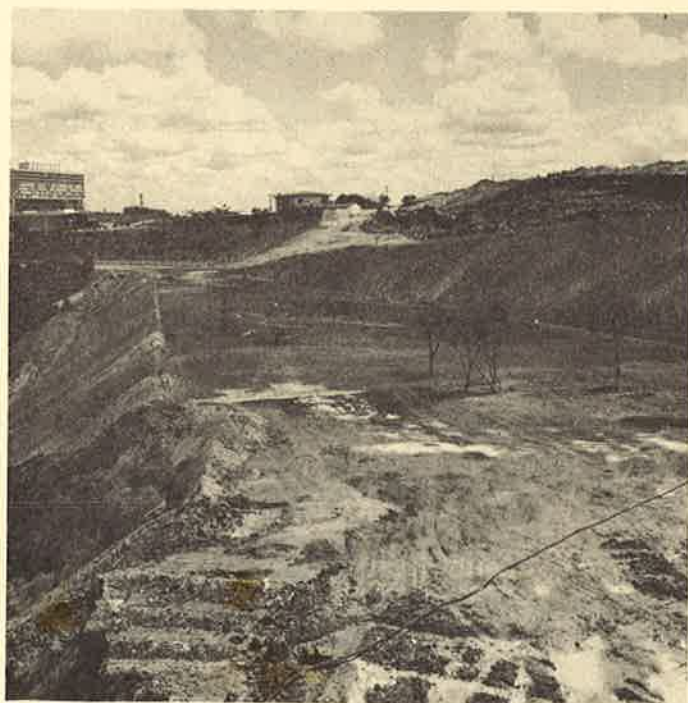
PATAMAR DAS QUADRAS DE TÊNIS
